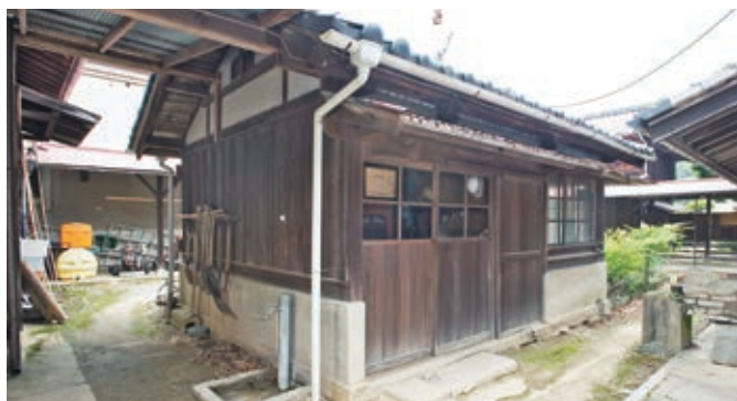
▲旧毛利家本邸内「台所付洗場」(現在は内外観とも非公開、立入禁止)
