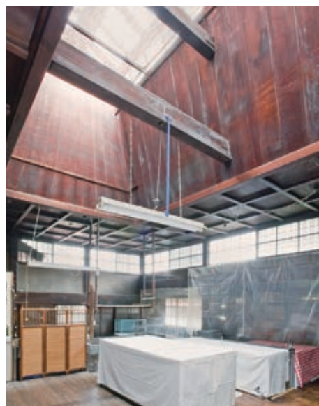
▲旧毛利家本邸内「台所」の内部 (現在は内外観とも非公開)
