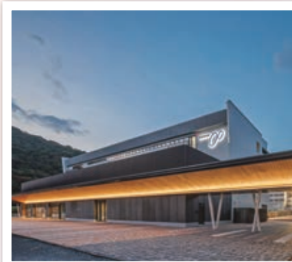
▲加工実績：防府競輪場新メインスタンド建設工事(建築主体)
