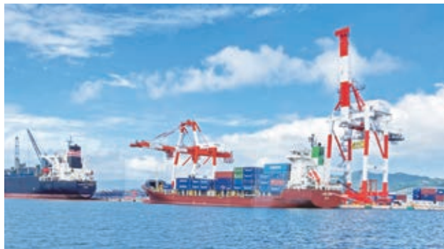
▲令和5年7月に2基体制となったガントリークレーン (中国地方整備局港湾業務艇「はくしゅう」船上より撮影)
