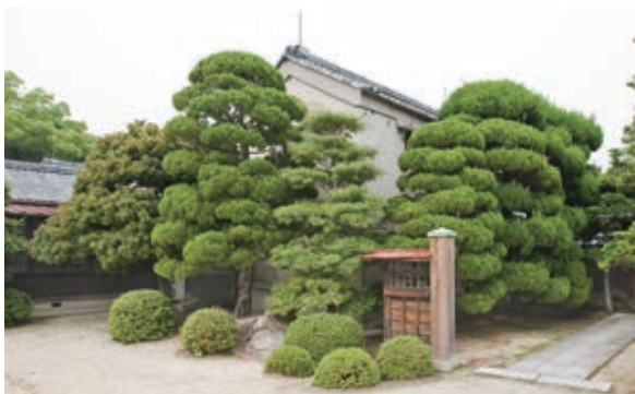
▲旧毛利家本邸内「台所付倉庫」の外観
