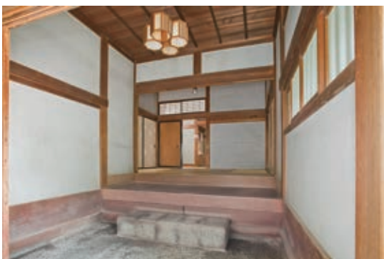
▲旧毛利家本邸内「内玄関」の内部
