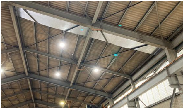
屋根からの輻射熱対策
